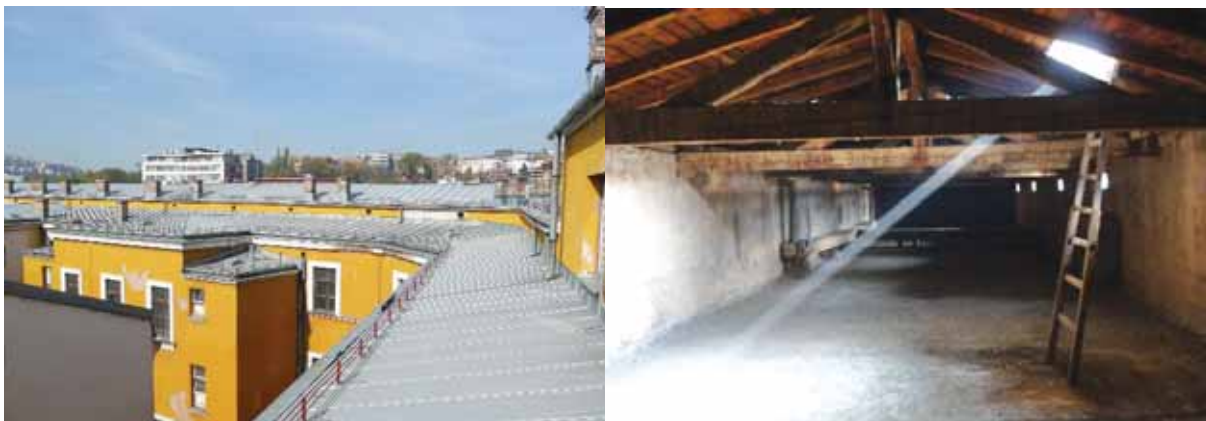
Слике 10.2. и 10.3.: Додатни простор у Општинском и Кантоналном суду у Сарајеву који би требао бити обуваћен реконструкцијом
