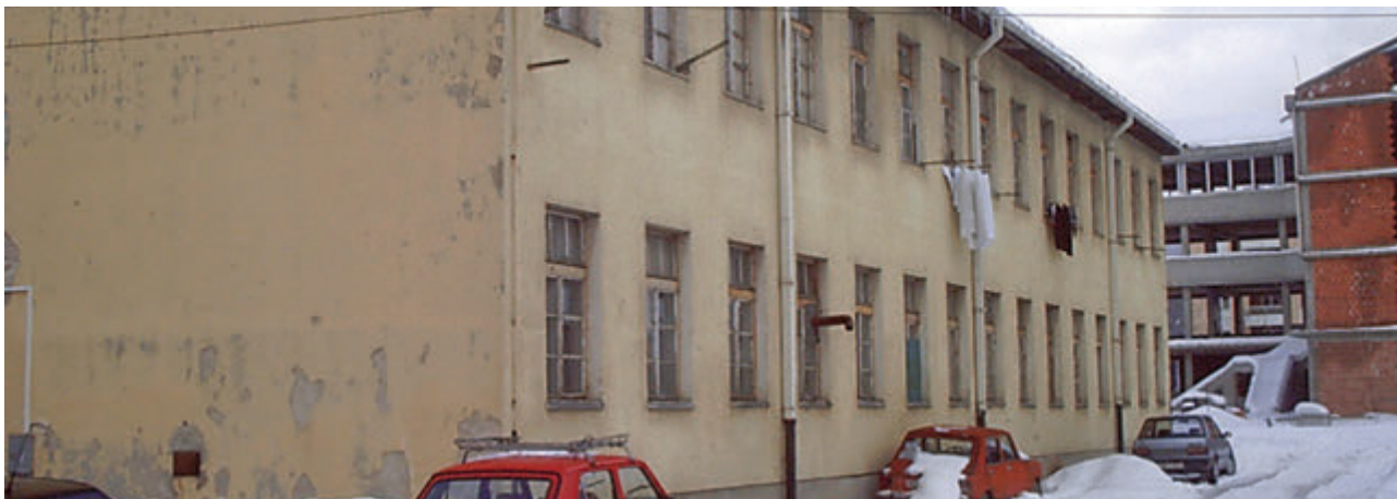
Okružni sud u Istočnom Sarajevu prije rekonstrukcije
