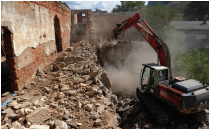
Radovi na rekonstrukciji buduće zgrade Općinskog suda u Mostaru
