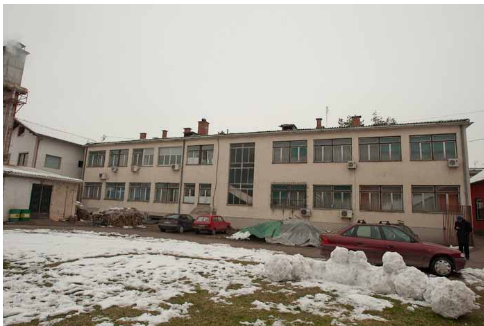
Слика 1.1.3: Зграда Основног суда у Модричи прије реконструкције
