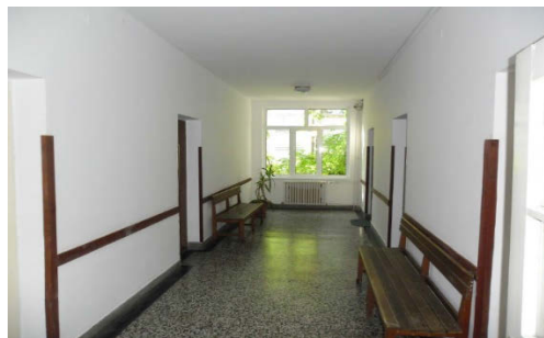
Slika 10: Izvršeni molerski radovi u hodniku suda
