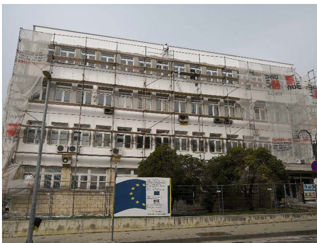
Slika 20: Radovi na fasadi zgrade Općinskog suda u Ljubuškom
